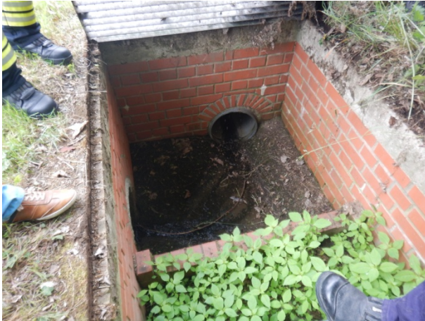
Einlauf in die Regenwasserkanalisation
