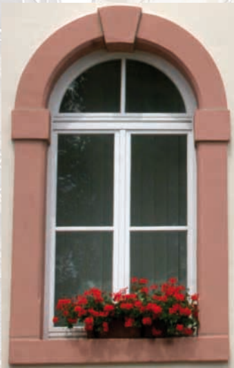
Abbildung: Positivbeispiel Fenstergestaltung
